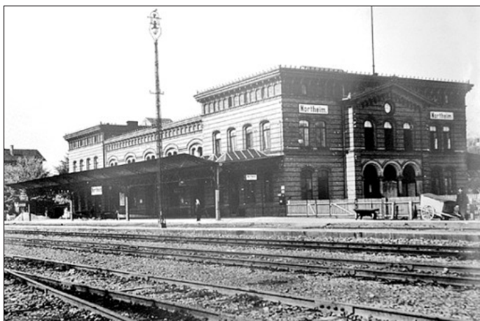
1883 neu gebaut: Bahnhof im Knotenpunkt Northeim. Repro: BB
