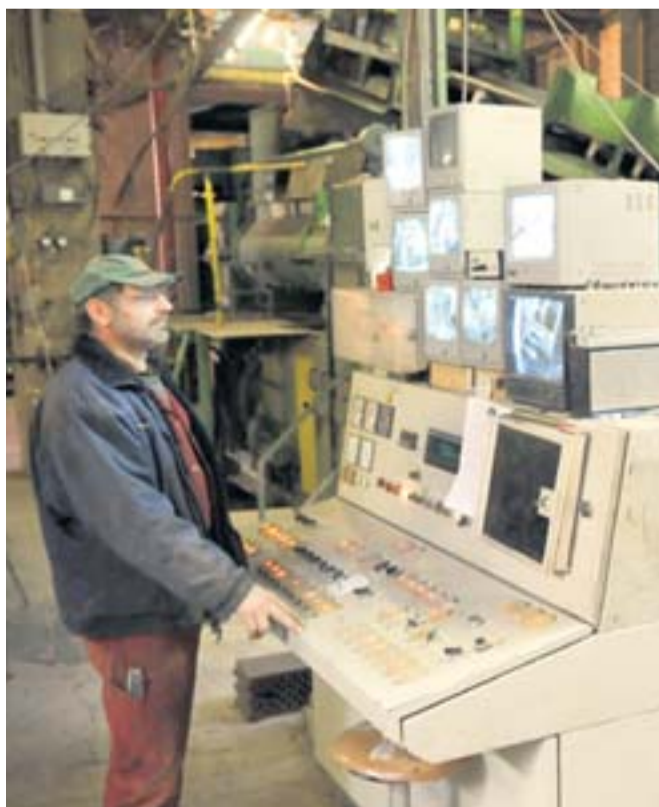
Während der laufenden Produktion: Mitarbeiter Adalbert Weber am Steuerpult.
