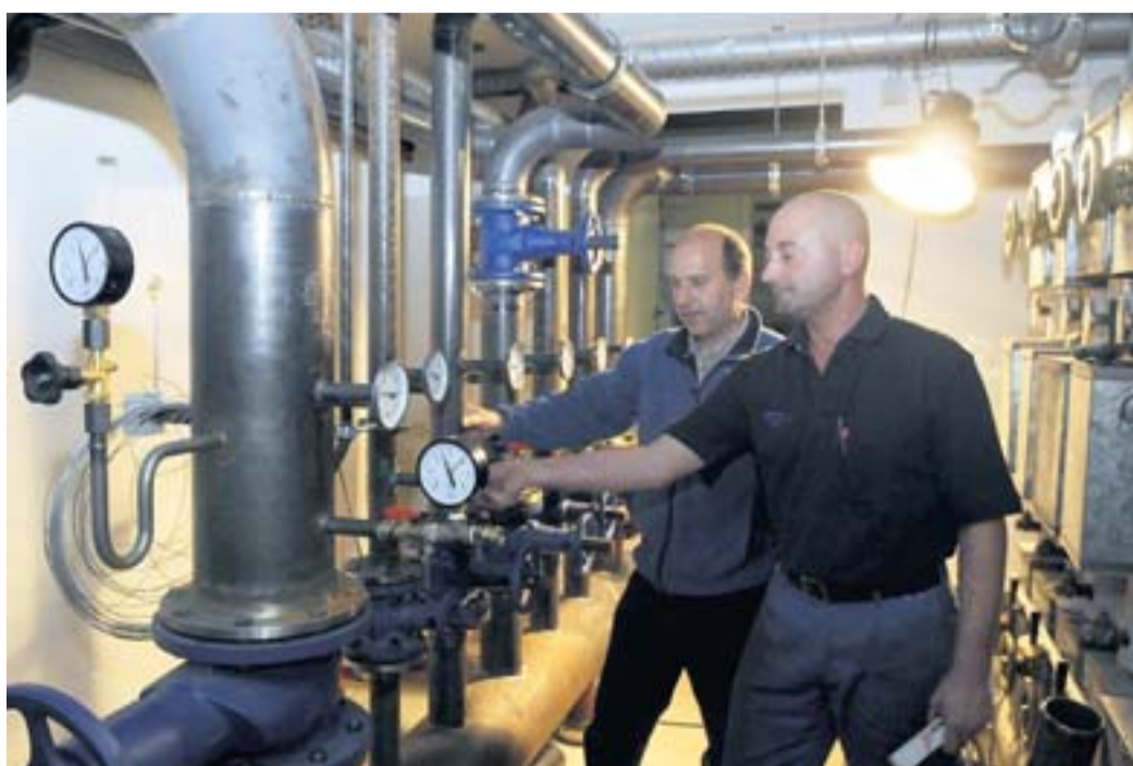
Teamarbeit: Detlef Buhr (links) und Obermonteur Sascha Brüller überprüfen in der Heizzentrale die Druckverhältnisse.
