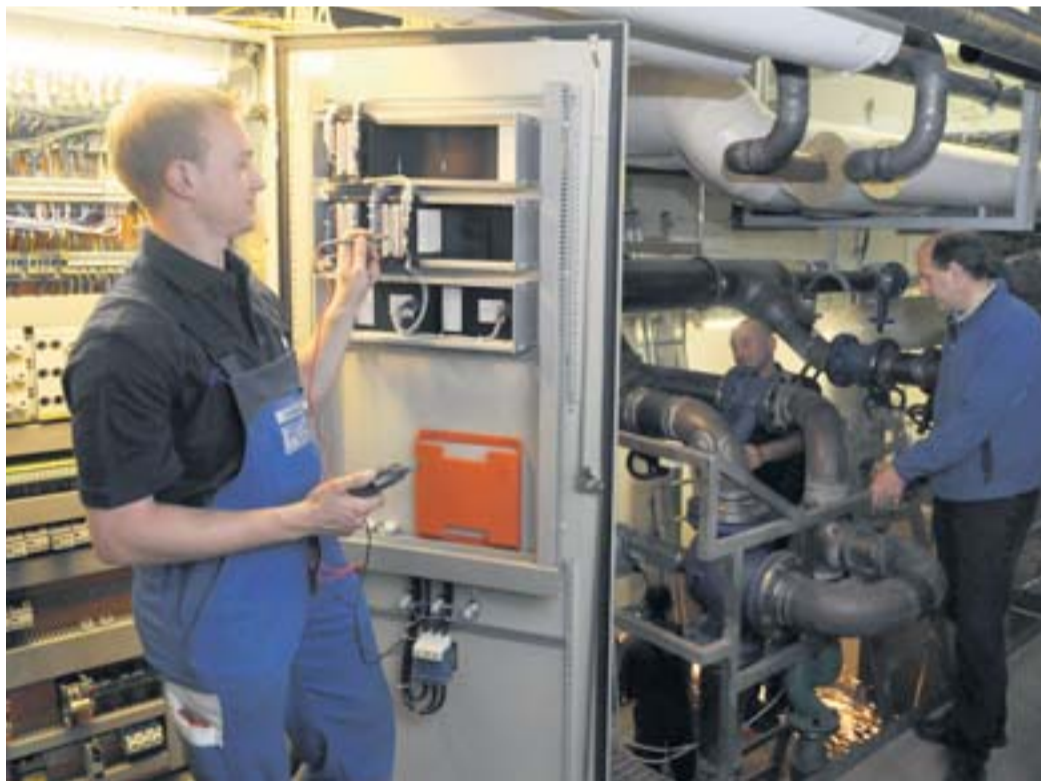
Im Weender Krankenhaus: Dennis Kleinsorge prüft Spannungsdurchgänge am Steuerschrank der Heizungsanlage.
